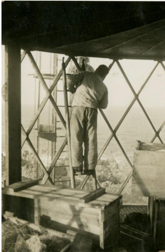
Pose des glaces de la nouvelle lanterne (Installing the windows for the new lantern), 15 November 1938, Reference: 25S 0367 014, Archives Départementales du Finistère,
