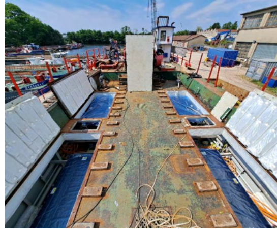
Création des locaux batteries
